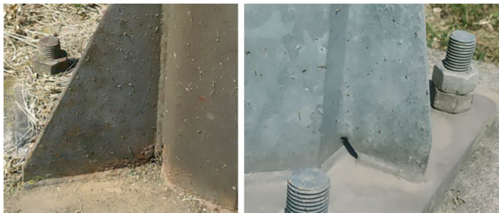
Slika 20. Lijevo – loše rješenje (pojava korozije zbog nakupljanja zavora na oštrim kutovima), a desno – dobro konstrukcijsko rješenje (mali džepovi eliminiraju nakupljanje zavora i pružaju bolju drenažu) [13]
